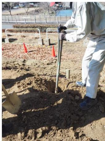
図14 親柱の穴を掘る
