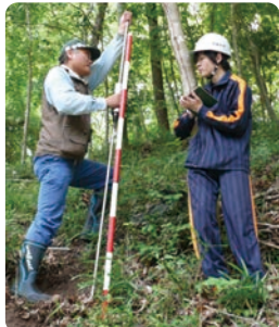
図2 簡易貫入試験の様子
