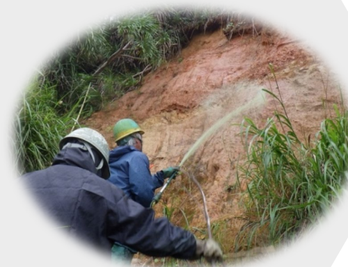
BSC工法イメージ ≡ 種子吹付工
