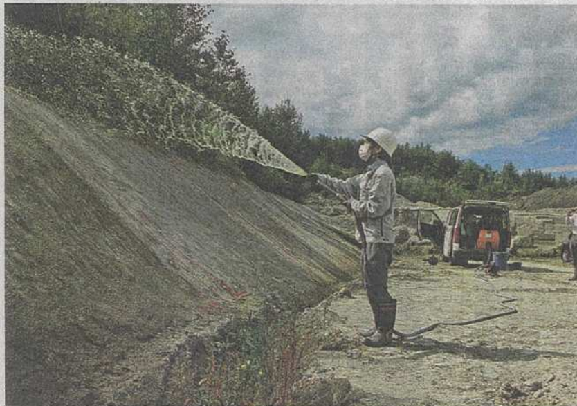
のり面に藻類などを吹き付けた施工試験＝13日
