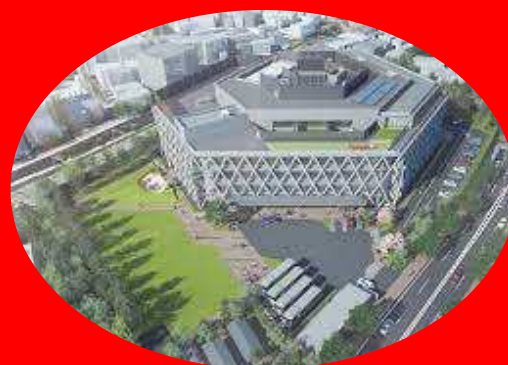
キューピー株式会社 仙川キューポート
