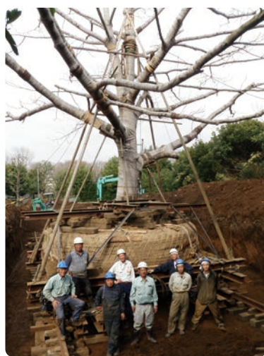
移植したイイギリの木。ジャッキと鉄製のレールを用いた移植工法を新たに開発し、施工された。
