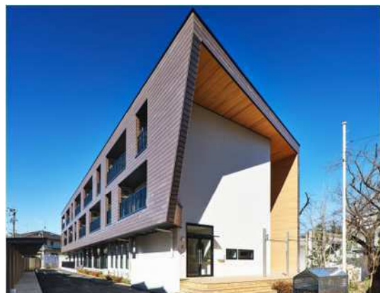
課外活動が活発化する活動環境の計画的な整備（青雲寮竣工）
