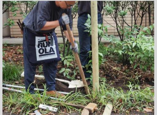
図12 突き棒で突き固める
