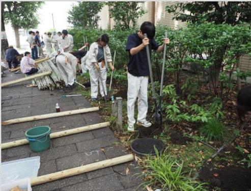
図8 親柱の穴を掘る
