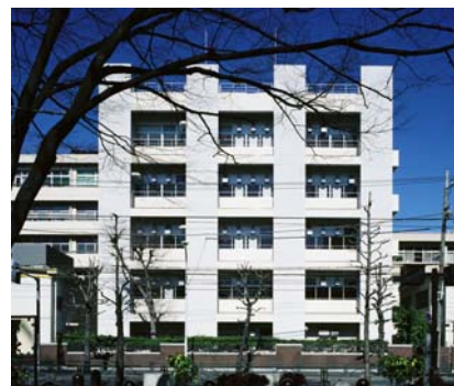
短期大学部醸造学科実験棟
