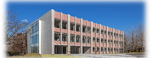
東京情報大学 看護実習棟建設
