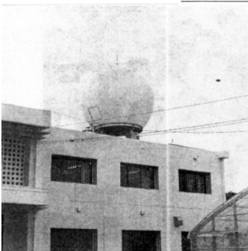
衛星データを受信するため屋上に設置されたパラボラアンテナ＝城辺農場、東農大宮古島亜熱帯農場
