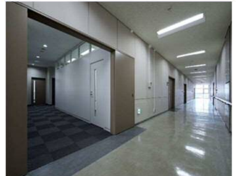
18号館改修工事
