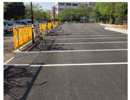
第一駐輪場整備
