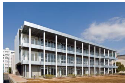
東京情報大学 〈 東アジア環境・経済研究棟建設 〉
