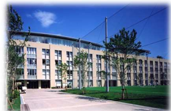
東京農業大学第一高等学校 東京農業大学第一高等学校中等部
