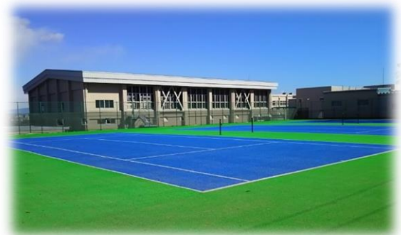
東京農業大学第二高等学校 テニスクレーコート3面改修
