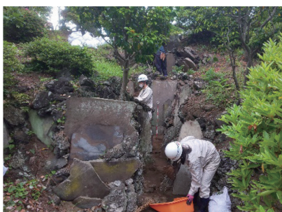
写真-1 陸奥宗光別邸跡・旧古河別邸庭園の保存のための池泉護岸の検出
