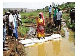
水管理研修の実習で設置した簡易分水工
