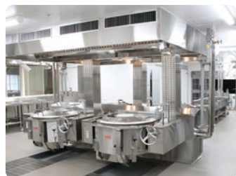
給食室 給食を作る厨房。食器やメニューの検討も進めている。
