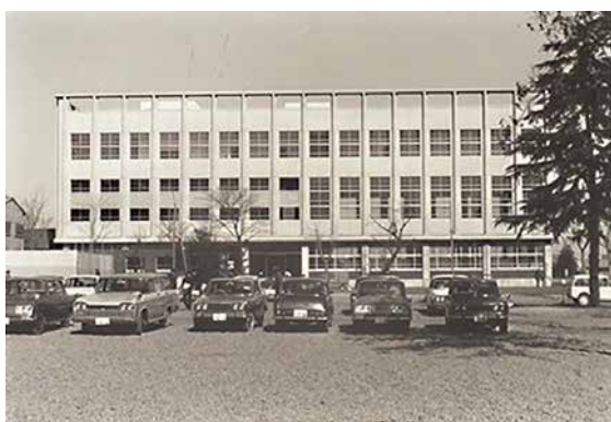
竣工当初（1968年頃）の図書館
