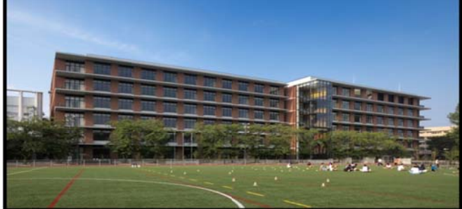
平成23年7月に完成した新1号館
