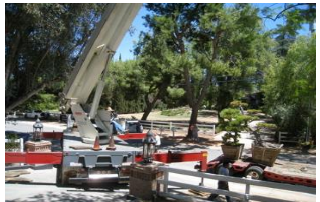
写真10 マスターヒルス個人邸作庭工事風景
