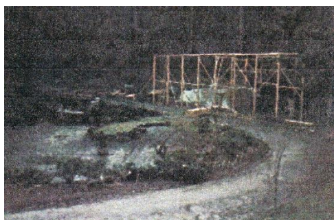
写真4 茶室の組立工程1
