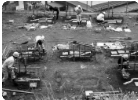
造園施工実習
