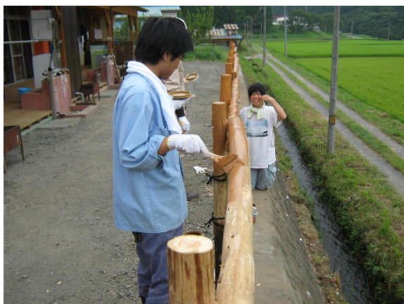
山王の里の丸太柵を防腐処理
