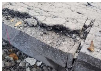
写真-3 開削地点 A(k.p. 216.04)のひび割れ発生状況
