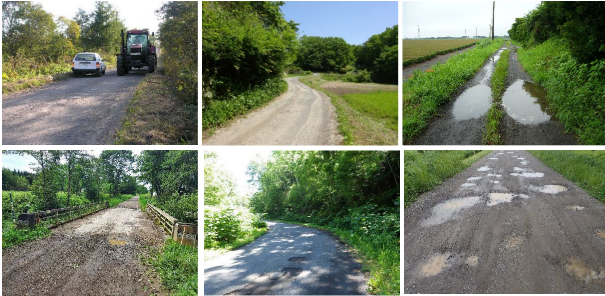
写真2 幅員狭小，蛇行，不陸の状況
