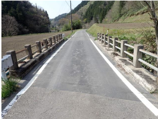
写真 11 施工後 1 年経過(2022 年 4 月撮影)
