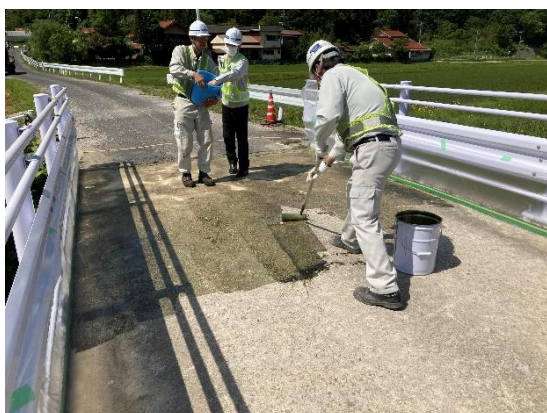
写真3 浸透防水型プライマー塗布状況
