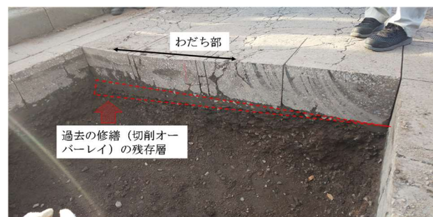
写真-4 開削地点 A(k.p. 216.04)の状況
