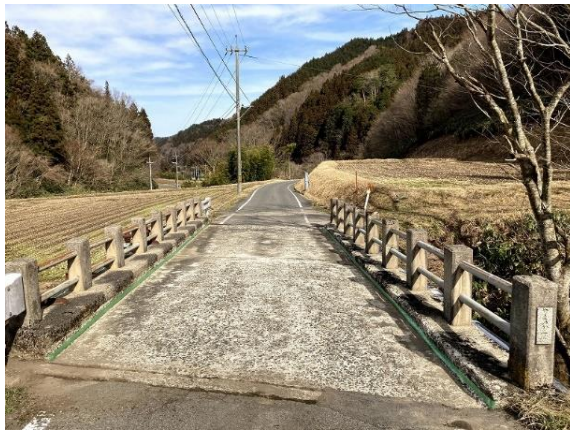
写真 7 施工橋梁(2021年3月撮影)
