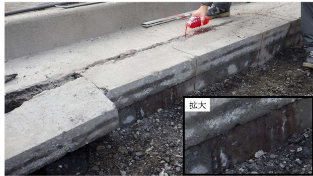
写真-5 開削地点 B(k.p. 216.39)の状況
