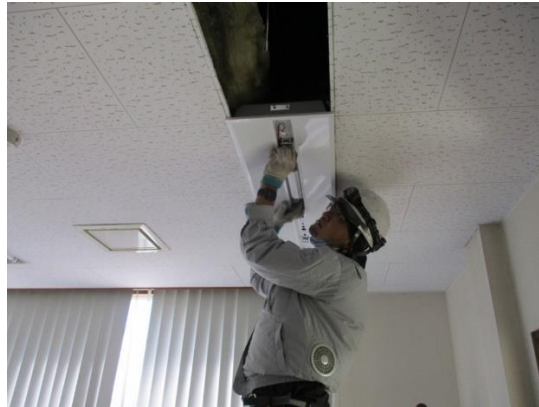
写真4 器具交換(埋め込み型)
