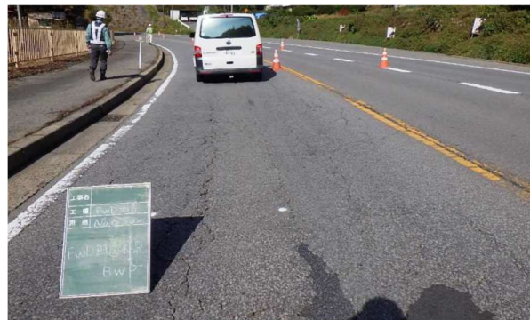
写真-1 開削地点 A(k.p.216.04)の路面状況
