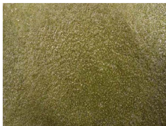
写真4 浸透防水型プライマー塗布後表面
