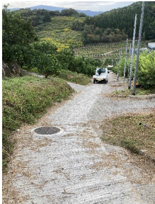
写真 1 コンクリート舗装の例
