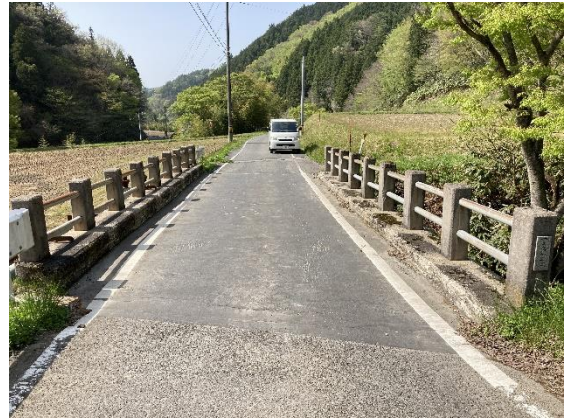
写真 12 施工後 2 年経過(2023 年 4 月撮影)
