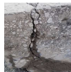
写真-3 開削地点 A(k.p. 216.04)のひび割れ発生状況
