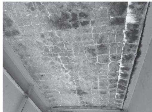
図1 鉄筋コンクリート床版部のひび割れ状況
