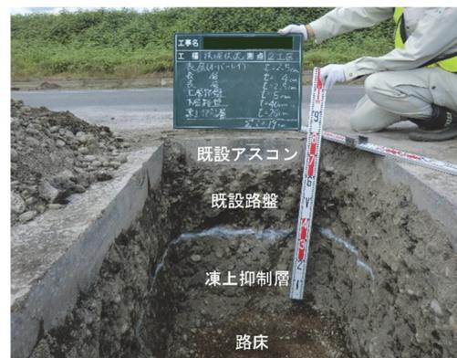
写真-1 既設舗装の開削断面
