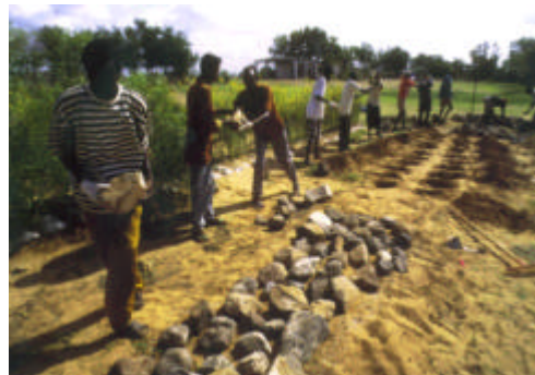
ストーンマルチ工法の作業状況
