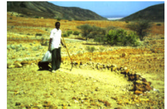
半月堤ウォーター・ハーベスティング 作業状況
