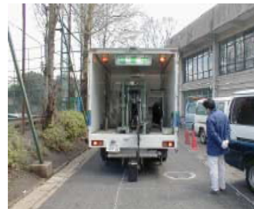
図-4 FWDによるたわみ測定状況
