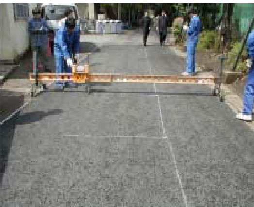
図-3 プロファイラによる路面形状測定状況
