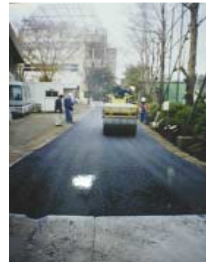
図-2 透水性舗装施工状況
