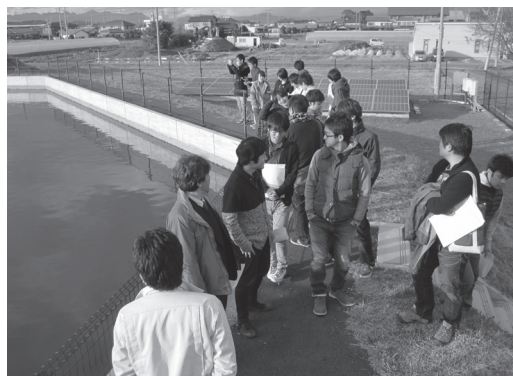
ファームポンドと太陽光発電
