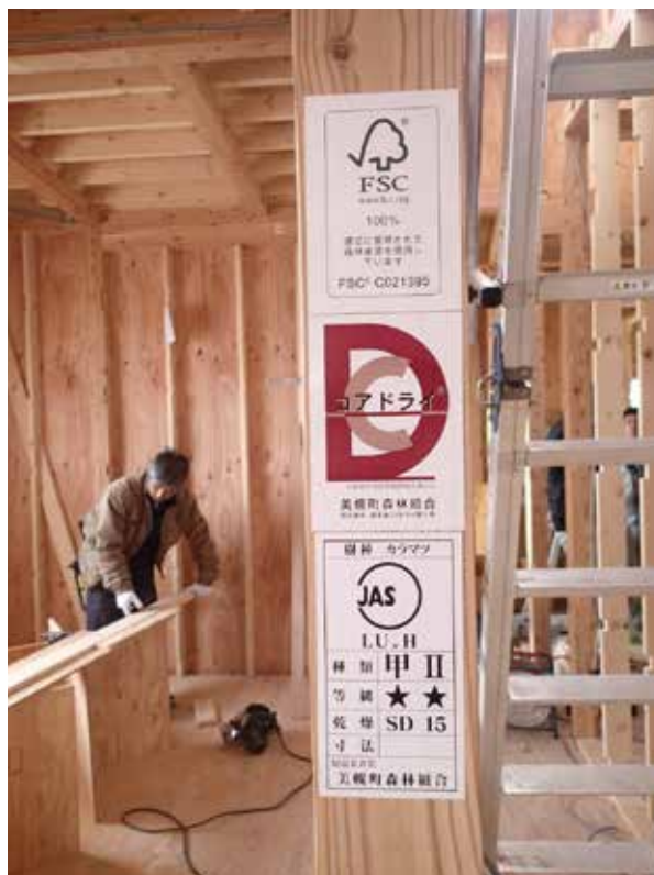
写真6. 個人住宅に使用され始めたカラマツの認証材 (FSCによる認証を受けた森林から生産された製材) (北海道・美幌町)
