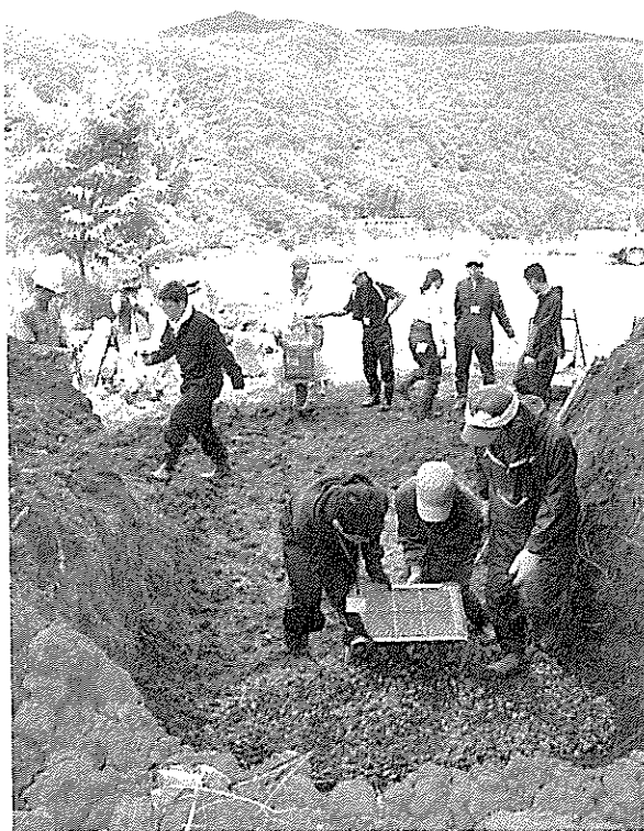
炭焼き窯の床面にする部分に砂利を敷いた
