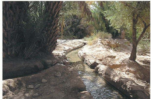
オアシス内の土水路
