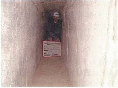
壁面をコンクリート化した水路
