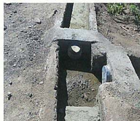
改修後のコンクリート水路と分水口
