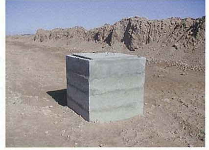
コンクリート蓋で覆った豎坑
