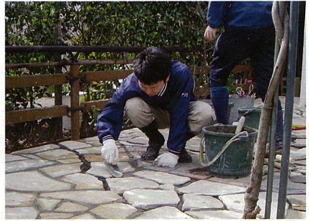
石張り舗装の作業（環境緑地学科）
